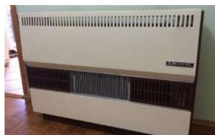
Slika 3-5 Pojedinačna plinska peć proizvođača IKOM
