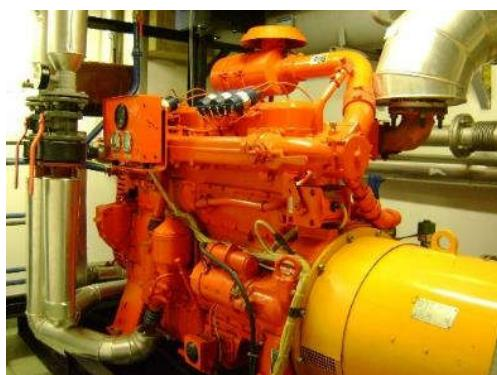
Slika 8-12 Kogeneracijsko postrojenje električne snage 75 kW i toplinske snage 150 kW na prirodni plin iz 2000. godine
