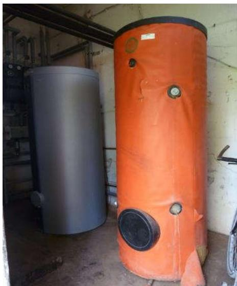
Slika 8-10 Dva solarna spremnika tople vode ukupnog volumena spremnika  $2 \times 500 \text{ L} = 1.000 \text{ L}$
