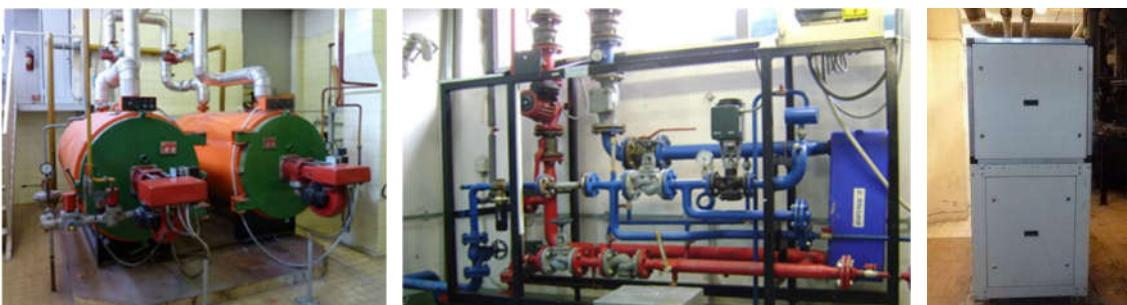
Slika 3-8 Uobičajeni izvori toplinske energije centralnog sustava grijanja
