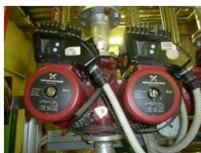
Slika 8-15 Dvojna izvedba cirkulacijske crpke na jednom polaznom krugu grijanja
