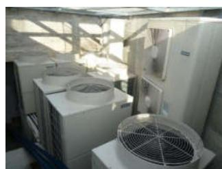
Slika 8-24 Vanjske jedinice VRV sustava proizvođača HITACHI s radnom tvari R410A za potrebe hlađenja/grijanja hotela
