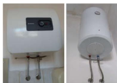
Slika 3-13 Električni akumulacijski zagrijivači vode
