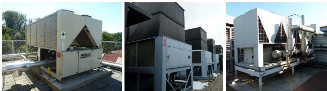
Slika 3-20 Kompresijski rashladni uređaji pogonjeni električnim motorom
