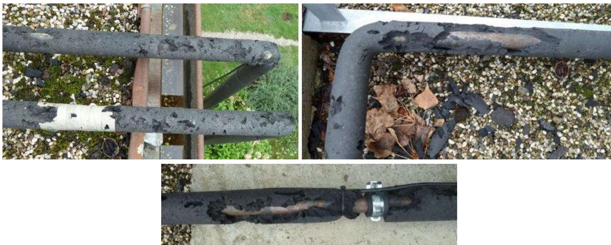
Slika 8-11 Neprikladna toplinska izolacija vanjskog dijela cijevnog razvoda do solarnih kolektora
