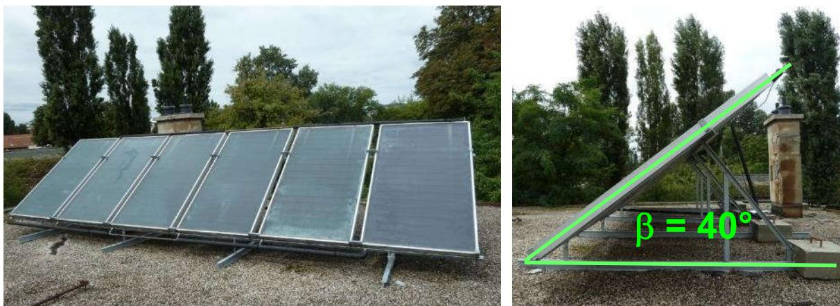
Slika 8-8 Pločasti solarni kolektori proizvođača TEHNOMONT tip SKT 40 na ravnom krovu zgrade
