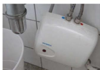
Slika 3-14 Električni protočni zagrijivač vode KONČAR tip ETA 0733 električne snage 3,5 kW
