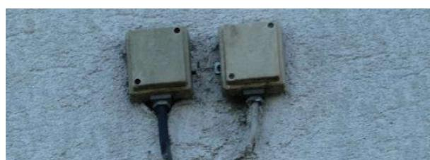
Slika 8-14 Dva vanjska osjetnika temperature za regulaciju rada sustava grijanja na sjevernom zidu škole (dva standardna kotla)
